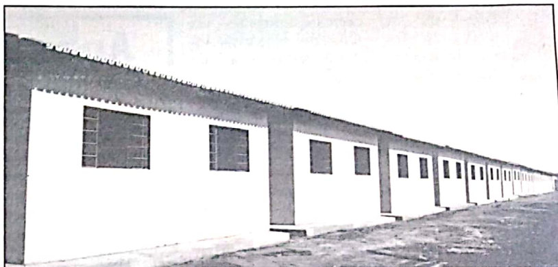
Uma rua do Residencial CAMPUS; unidades concluídas e o asfalto já está chegando...
