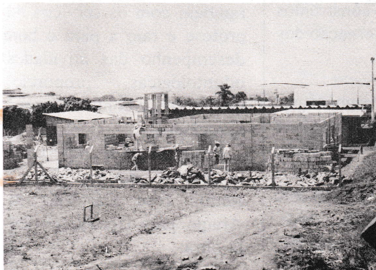
A obra da creche está quase concluída.
